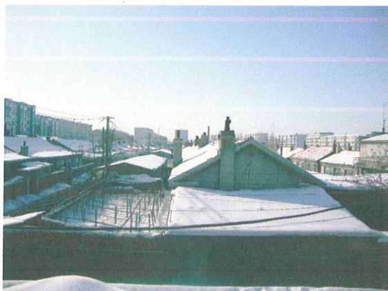
院区西侧棚户改造区
