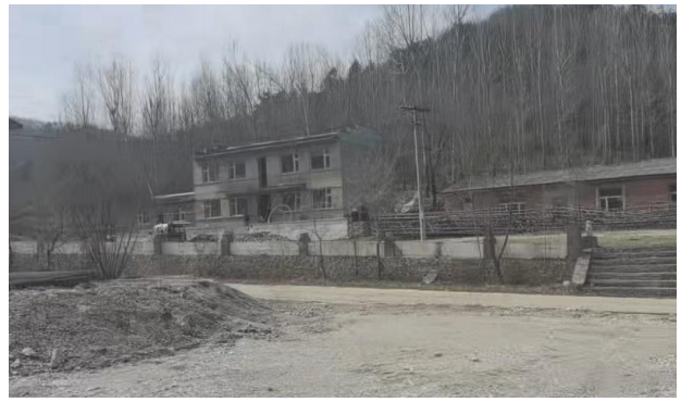
项目西侧现状
