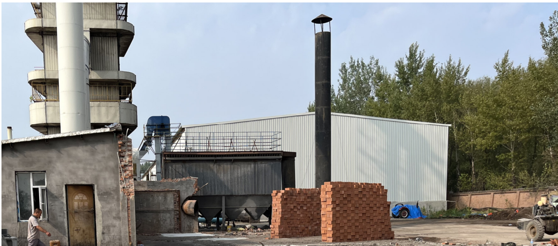
原有热风炉机房位置及热风炉烟囱
